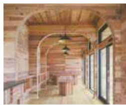
CLT工法を使った滋賀県初の建築物。床、壁、屋根の構造材として滋賀県産のスギ(びわ湖材)を使ったCLTを全面使用。成熟した木の伐採や間伐で新たな森を再生する森林保護に貢献。木質の美しさ、デザイン性の高さだけでなく、優れた断熱性や耐震性など高機能を兼ね備えています。
