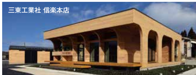
CLT工法を使った滋賀県初の建築物。床、壁、屋根の構造材として滋賀県産のスギ(びわ湖材)を使ったCLTを全面使用。成熟した木の伐採や間伐で新たな森を再生する森林保護に貢献。木質の美しさ、デザイン性の高さだけでなく、優れた断熱性や耐震性など高機能を兼ね備えています。
